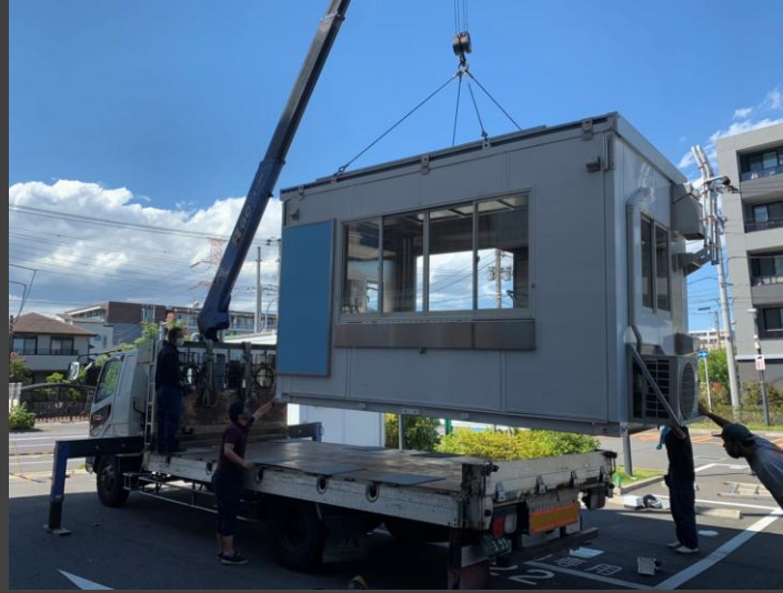
コンテナを吊り上げ
