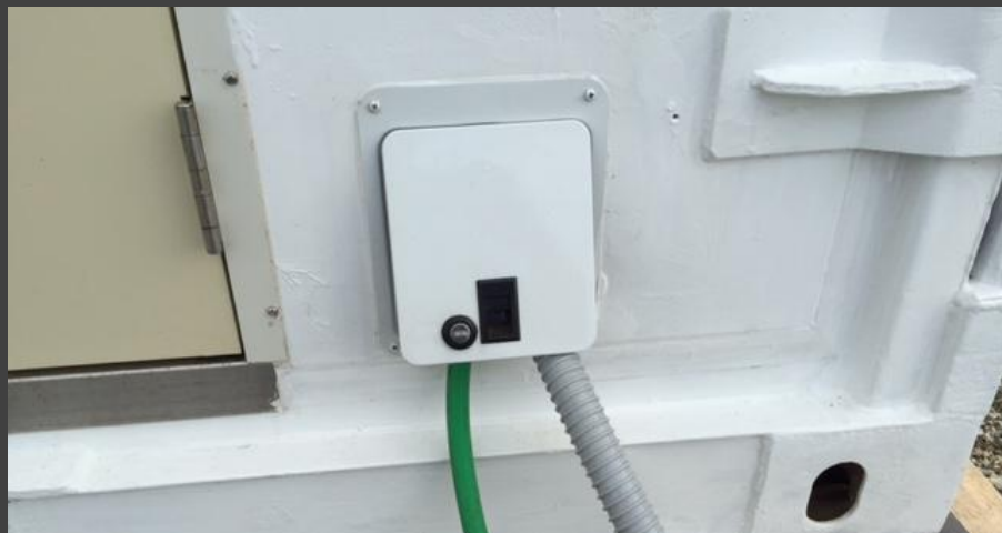
給排水取り出し口 直結式 (清水 1/2ボールバルブフレキつなぎ) (排水 排水ホース34mm)
