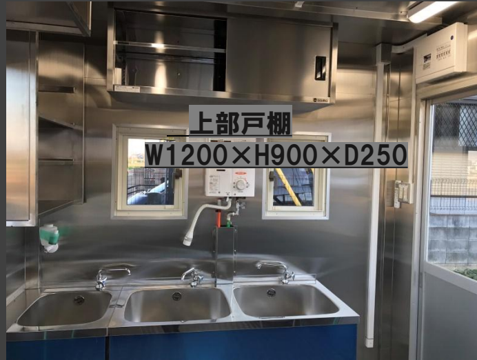
2層シンク+1層シンク 2層シンクサイズW525×D475×H205 手洗いW375×D450×H205
