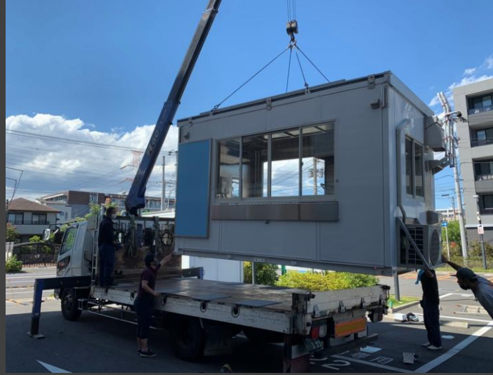
コンテナを吊り上げ
