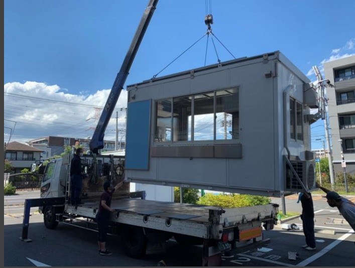
コンテナを吊り上げ
