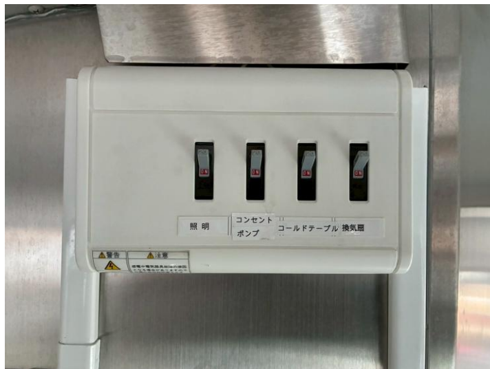
外部電気引き込みブレーカー
