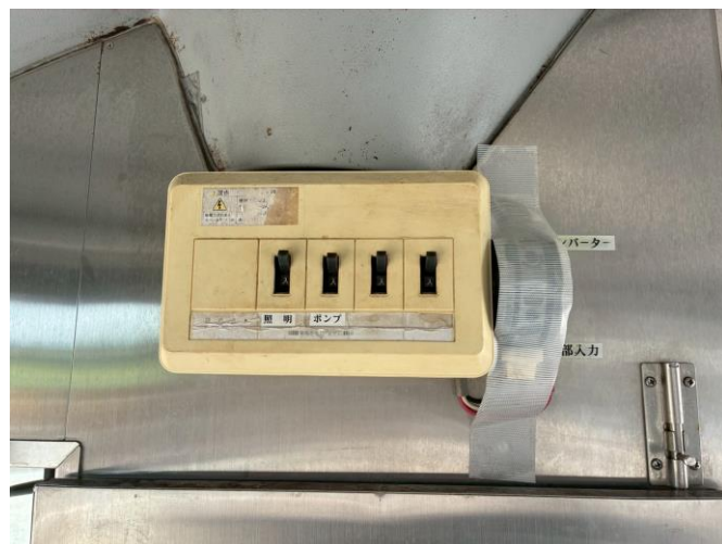
外部電源引き込みブレーカー
