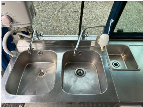
2槽シンク+手洗いシンク
