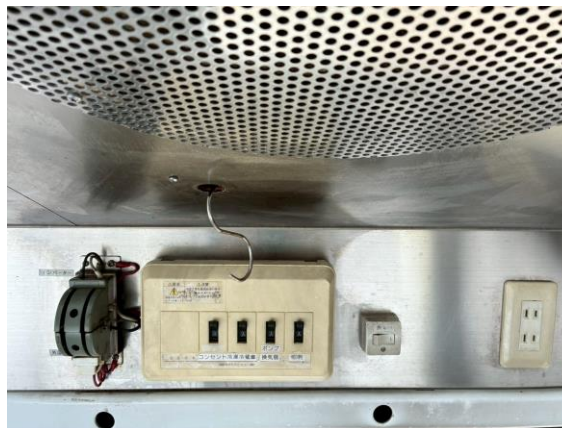
外部電気引き込みブレーカー
