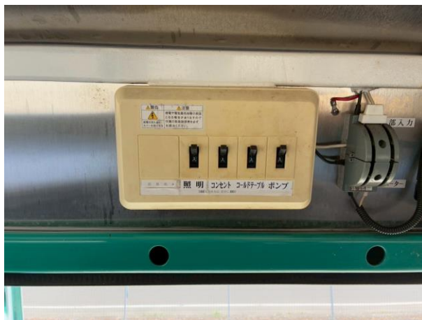
外部電気引き込みブレーカー
