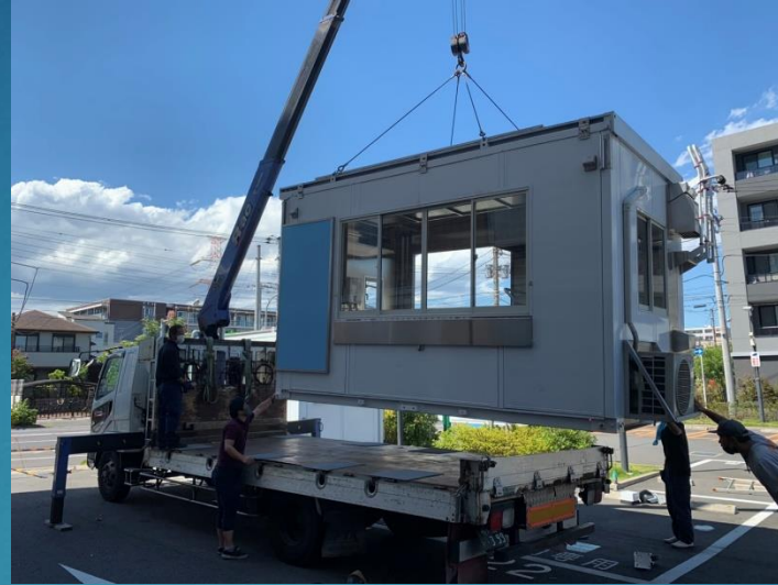
コンテナを吊り上げ
