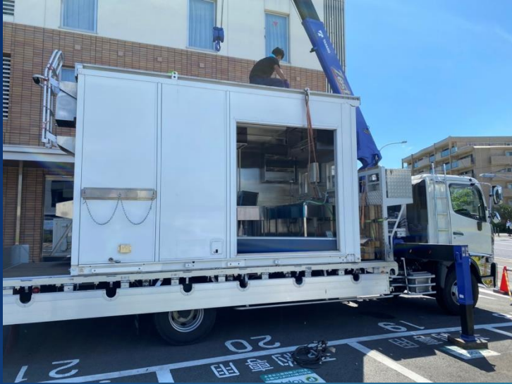
設置場所を決めコンテナを下ろす位置の真横に止めます。
