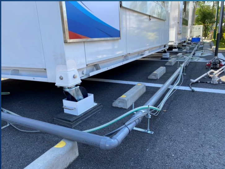
キャスター取り付け固定 水平になるように板で調整します。
