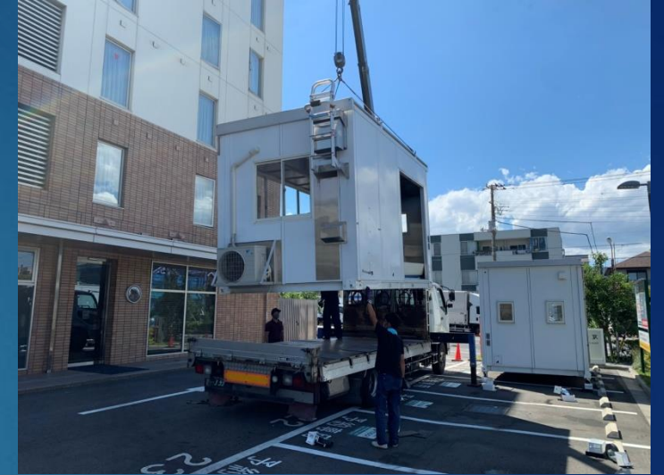
コンテナ下ろす際に キャスターを取り付けます
